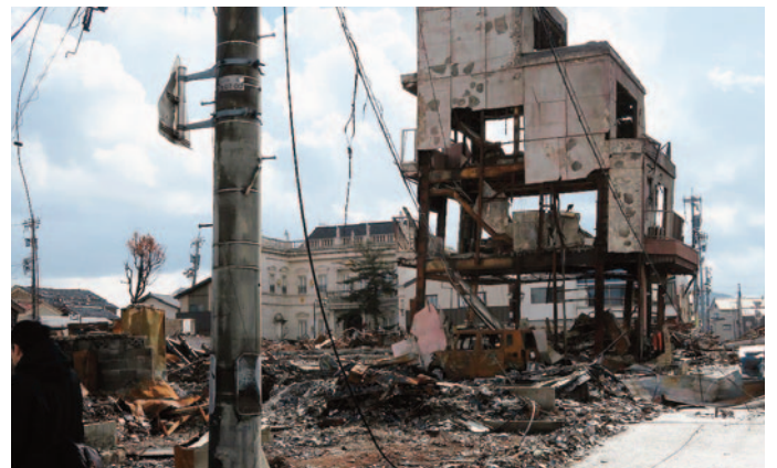
輪島朝市の火災跡
