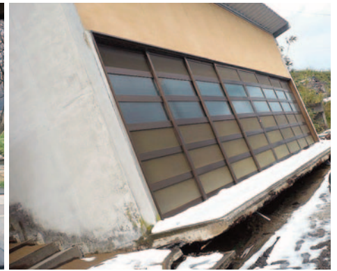
内灘町 液状化でうねった道路と傾いた建物
