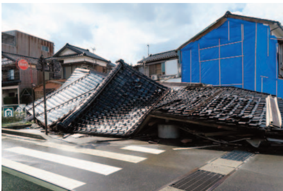
輪島郊外の住宅被害
