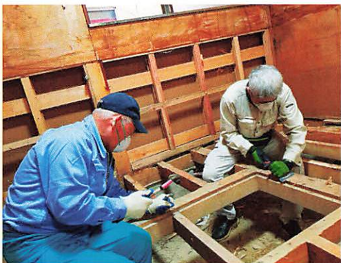
ボンドで接着されている床板と根太材を剥がす
